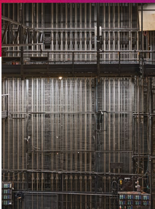
Bilder Thomas Florschuetz, Dokumentation der Sanierungsarbeiten
